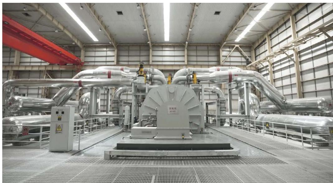
Dieser 100-MW-Druckluftspeicher steht im nordchinesischen Zhangjiakou. Er kommt ohne fossile Brennstoffe aus, ist also adiabatisch.
